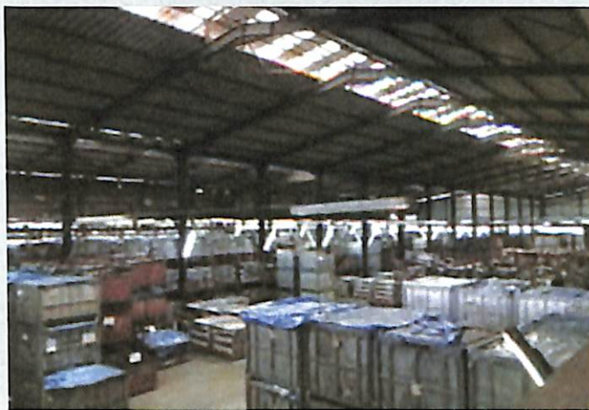
Photo 5 : Hangar de stockage de la SOGB ©2014
