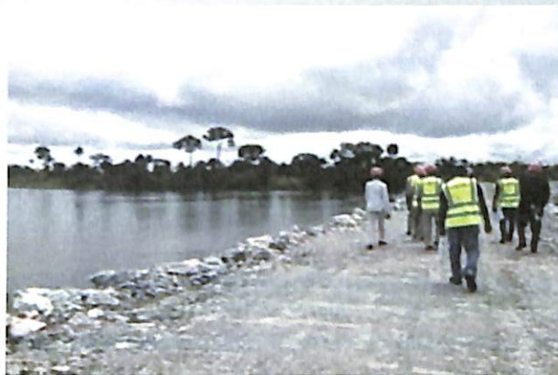
Photo 9 : Site de construction du Barrage © 2014
