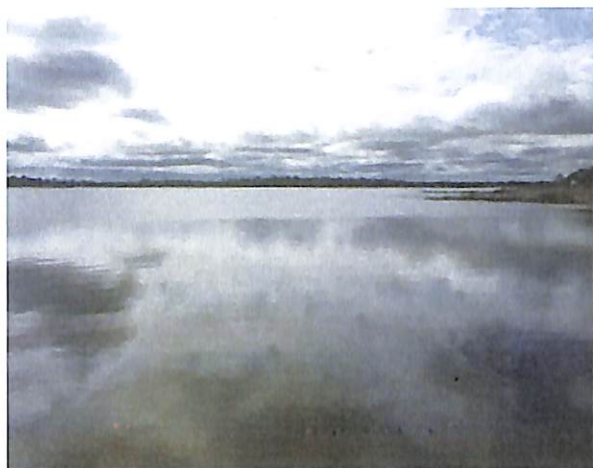
Photo 1 : Barrage de la Loka © 2014
