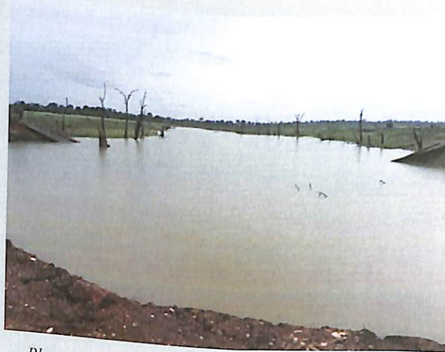
Photo 14 : Site de construction du pont à Béoumi © 2014
