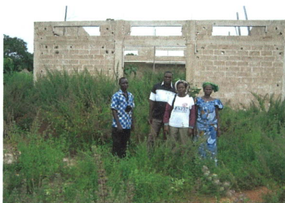
Magasin en construction à Karakoro
