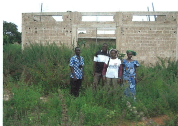
Magasin en construction à Karakoro
