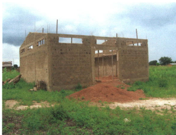
Image 2: Magasin de Karakoro en construction
