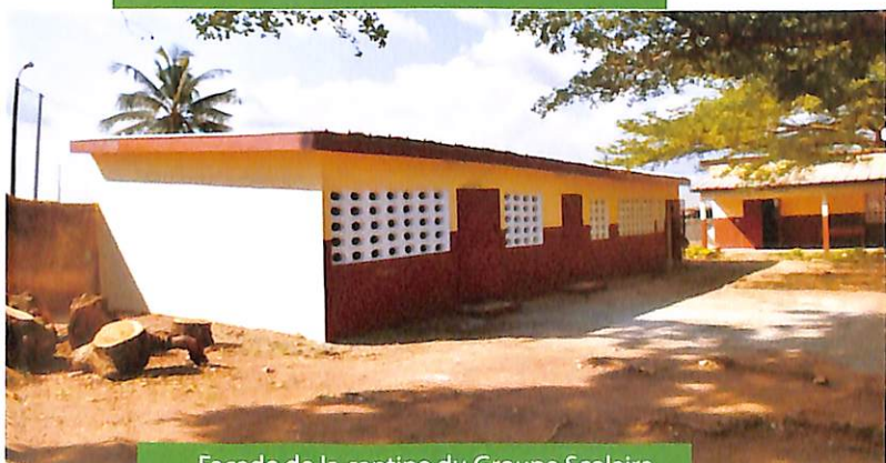
Façade de la cantine du Groupe Scolaire HKB reconstruite par la Fatom
