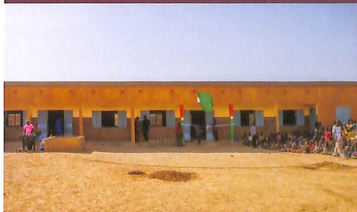
Une Vue du bâtiment construit.
