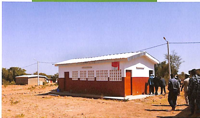
Les toilettes du Groupe Scolaire Ali Kader Coulibaly de M'bengué, construites par la Fatom
