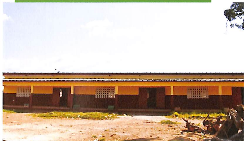
Façade d'un bâtiment (de trois salles de classe) réhabilité par la Fatom au Groupe Scolaire HKB d'Abengourou
