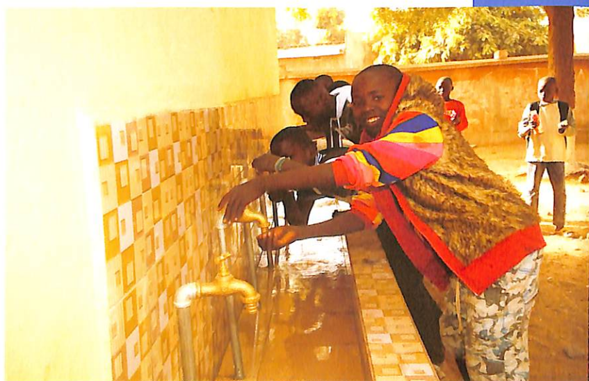
Construction de Lave-mains au Groupe Scolaire Fadjuila à Bamako (Mali)
