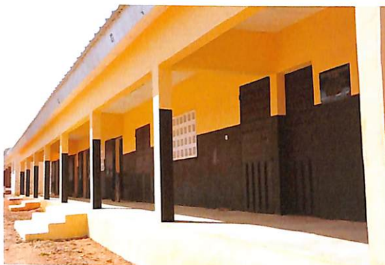
Vue extérieure d'un bâtiment
