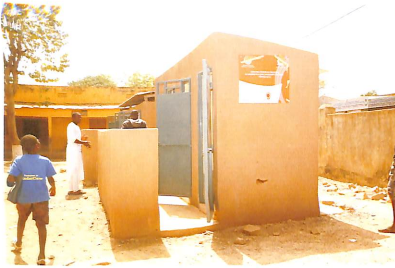
Bloc de 04 latrines sèches construites au Groupe Scolaire Dianguina Coulibaly au Mali.
