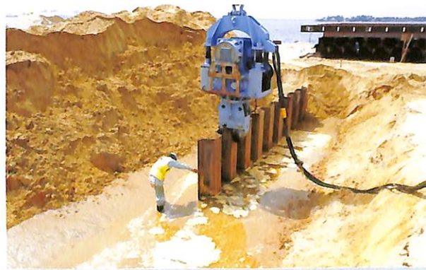
Travaux de battage des palplanches de quai.
