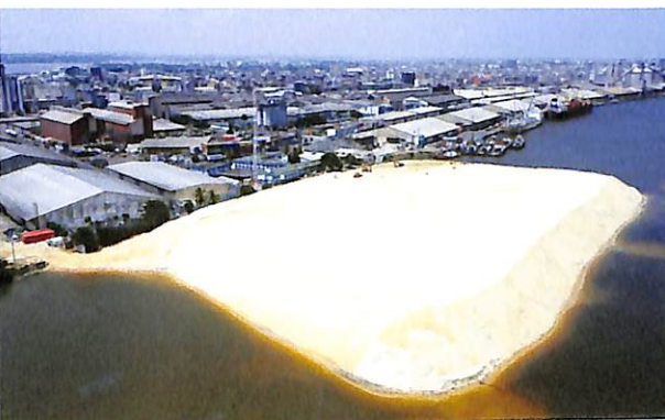
Fin du remblai.
