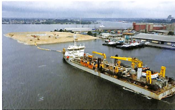
Évolution du remblai au moyen d'une drague auto-porteuse.
