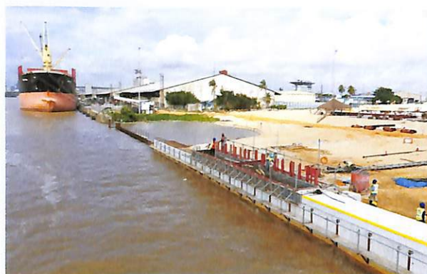
Réalisation de la poutre de couronnement en béton armé.
