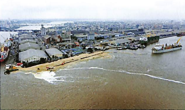
Début du remblai au moyen d'une drague auto-porteuse.
