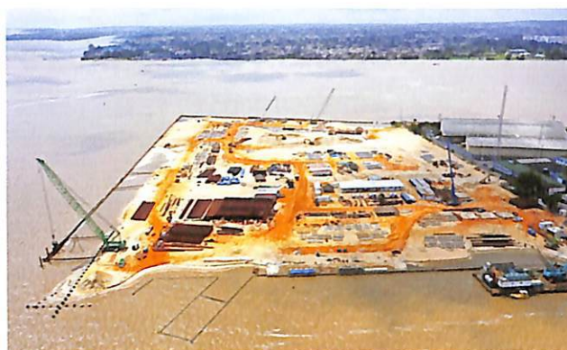
Évolution du battage des palplanches de quai.
