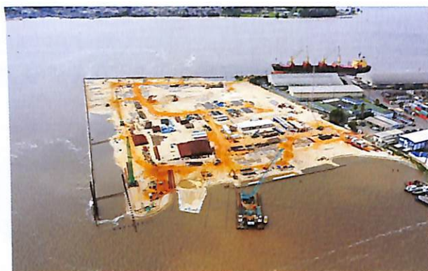
Évolution du battage des palplanches de quai.
