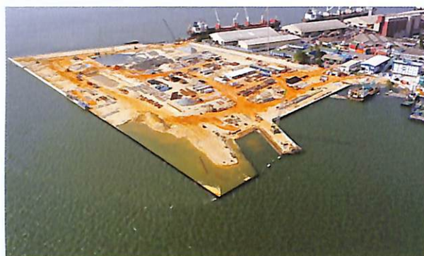
Fin des travaux de battage des palplanches de quai.
