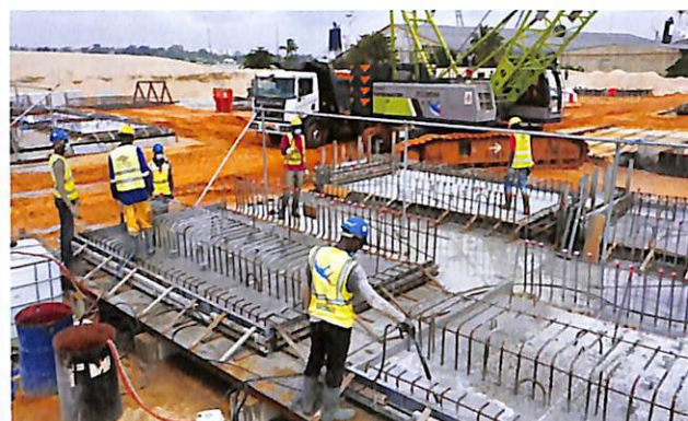
Confection des éléments préfabriqués de la poutre de couronnement.
