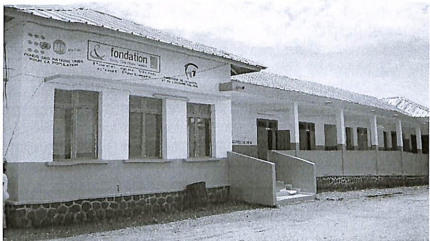
Photo 1 : bloc gynéco-obstétrique du CHR de Dimbokro réhabilité
