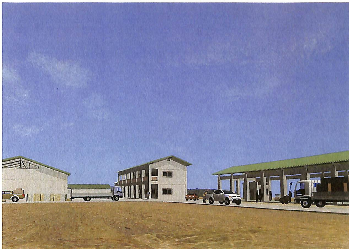
Vue intérieur du débarcadère
