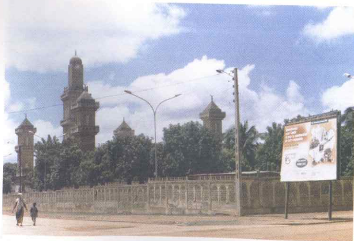
Vue d'un quartier électrifié
