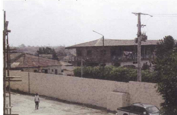
Vue d'un poteau électrique au quartier Tazibo
