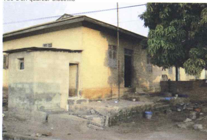
Vue d'un quartier électrifié
