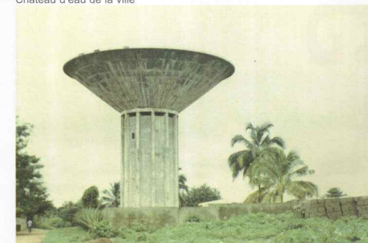
Château d'eau de la ville
