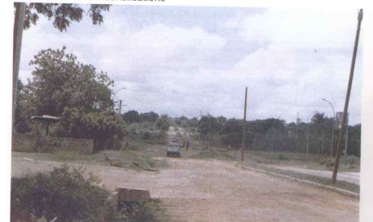
Une voie avec des canalisations
